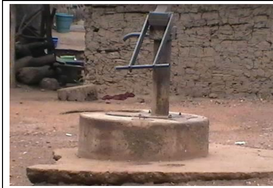
Pompe non entretenue
