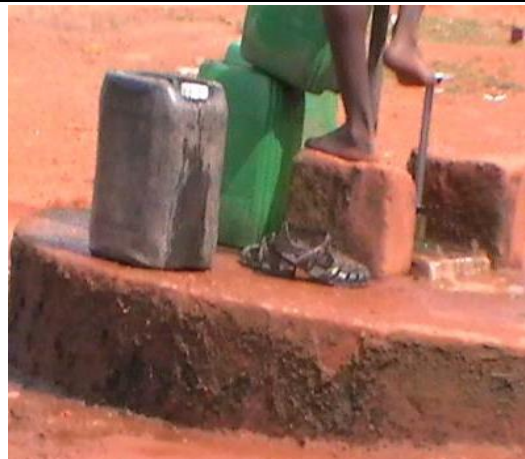
Pompe non entretenue
